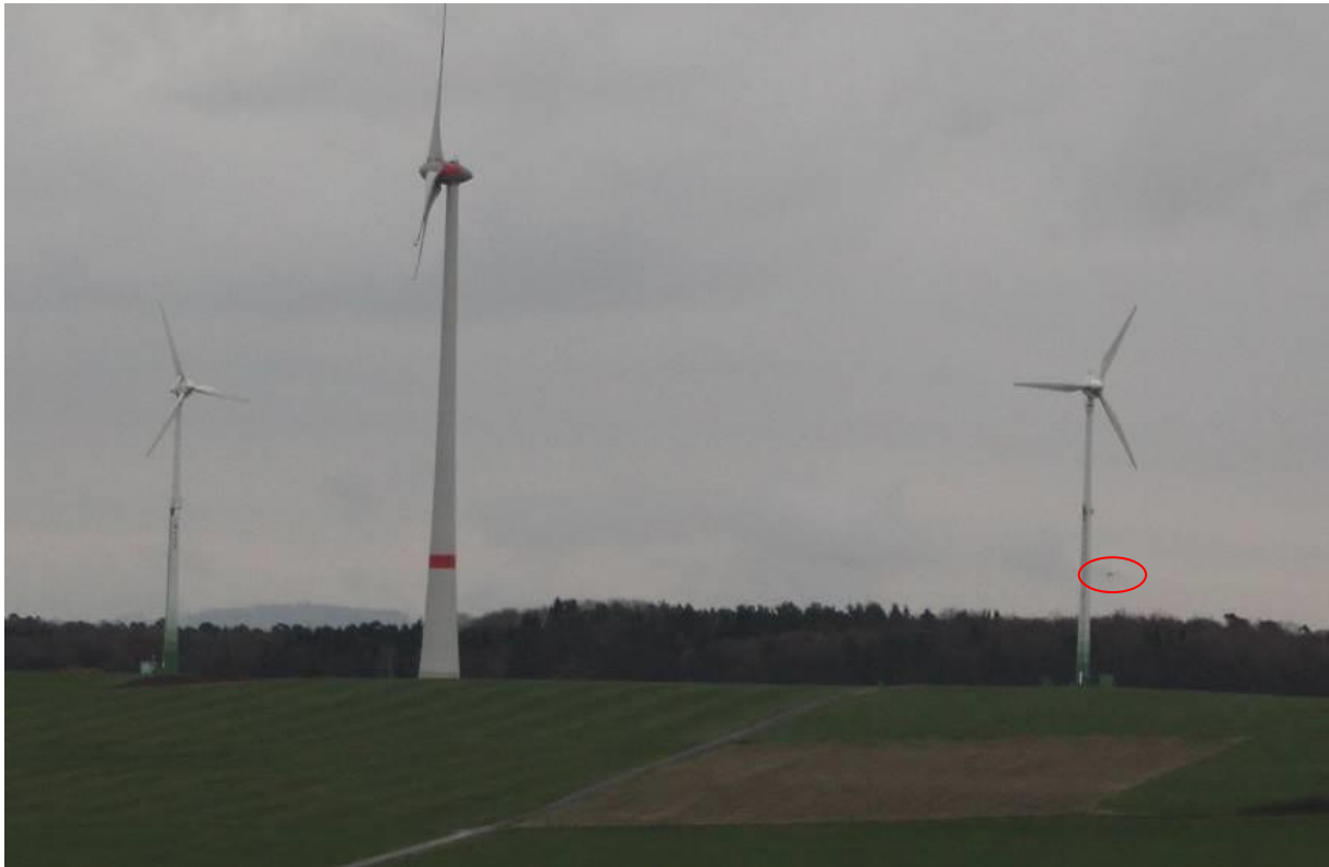
Abb. 59: Schwarzstorch fliegt an einem Windpark ohne erkennbare Verhaltensreaktion vorbei. Der Windpark liegt zwischen Brut- und essentiellen Nahrungshabitaten. Brutstandort ist in 2,5 km zur nächsten Anlage. Im Beobachtungsjahr 2016 war die Brut mit 4 Jungvögeln erfolgreich. Etwa 10% aller Flugbewegungen waren im Wirkraum der Anlagen und somit im Risikobereich einer potenziellen Schlagwirkung für die Störche.
